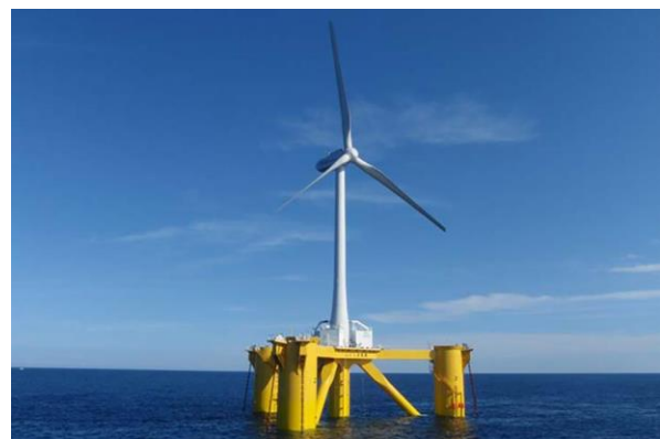
Floating Offshore-Windkraftanlage vor Fukushima (Quelle: Hitachi)
