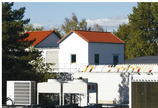
各調査目的に合わせて使用できるテスト用ハウス
